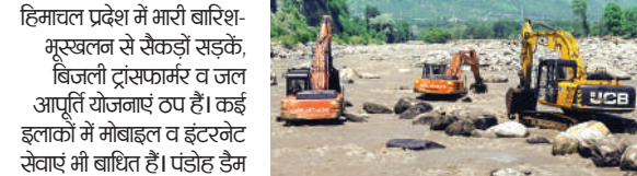
कुल्लू के रायसन क्षेत्र में सड़क मरम्मत की जा रही
